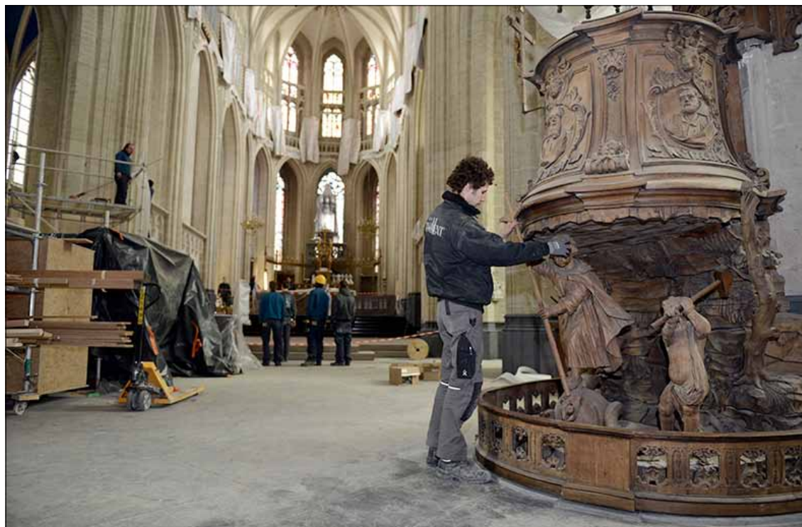
Arbeiders leggen de laatste hand aan de restauratie van de basiliek van Halle. © Luc Gordts
